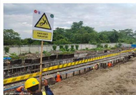
Pekerjaan Penimbunan Peron Stasiun Helvetia
