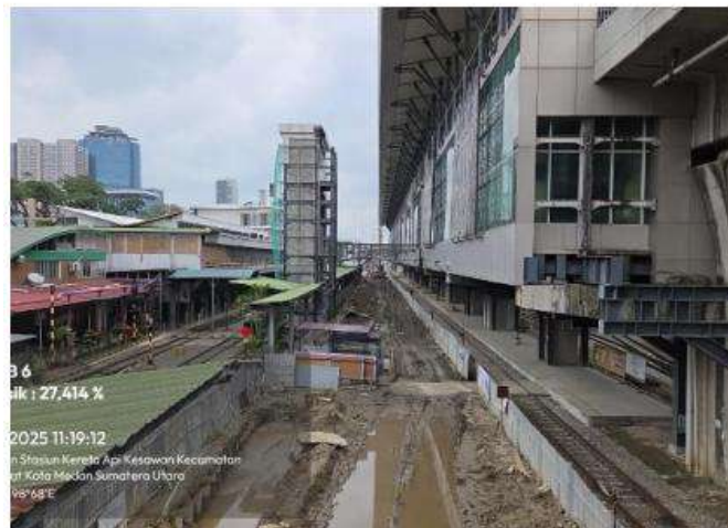
Pekerjaan Pembongkaran JPO
