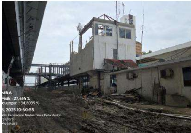
Pembongkaran ruang PAP
