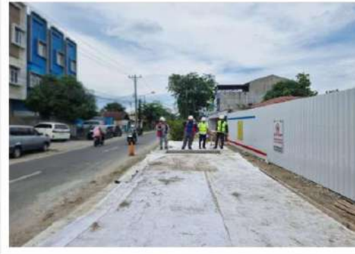
Pekerjaan Jembatan Akses Pintu Masuk Stasiun Helvetia
