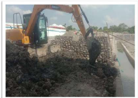
Pekerjaan Dinding Penahan Tanah (Pas. Batu kali) Stasiun Helvetia
