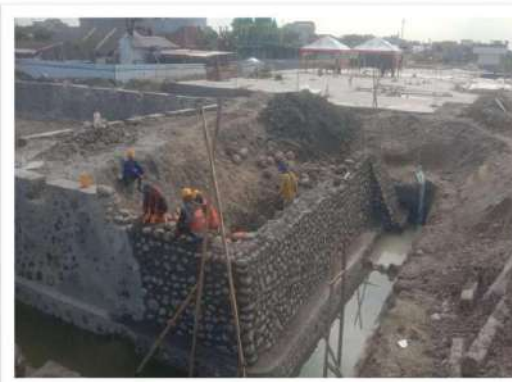
Pekerjaan Dinding Penahan Tanah (Pas. Batu kali) Stasiun Helvetia
