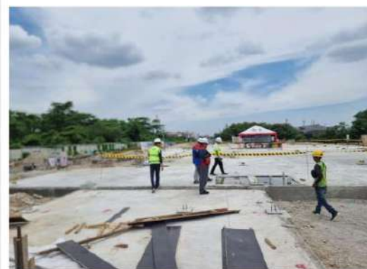
Pekerjaan Bangunan Stasiun Helvetia
