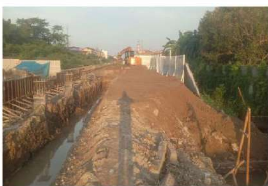
Pekerjaan Penimbunan Peron Stasiun Helvetia
