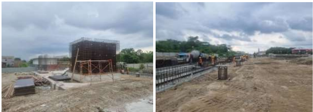
Gambar 2. 4 Dokumentasi Progress Kegiatan Pembangunan JLKAMB
