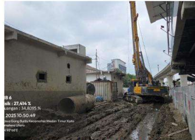
Pekerjaan borepile dia. 1200 mm dan dia. 1000 mm
