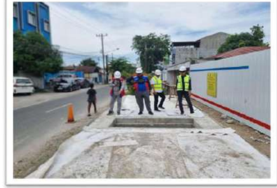
Pekerjaan Jembatan Akses Pintu Masuk Stasiun Helvetia
