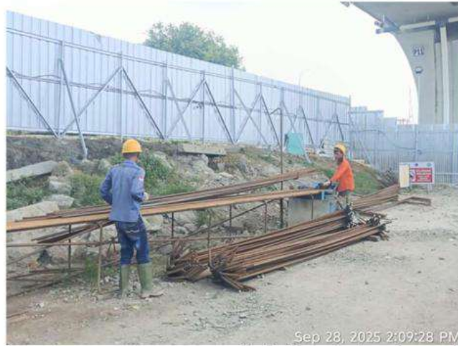
Fabrikasi dan Instal Pembesian Pier Table
