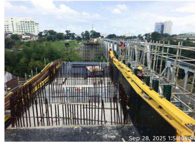
Fabrikasi dan Instal Pembesian Pier Table
