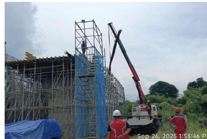
Instal besi Pier table pada P7
